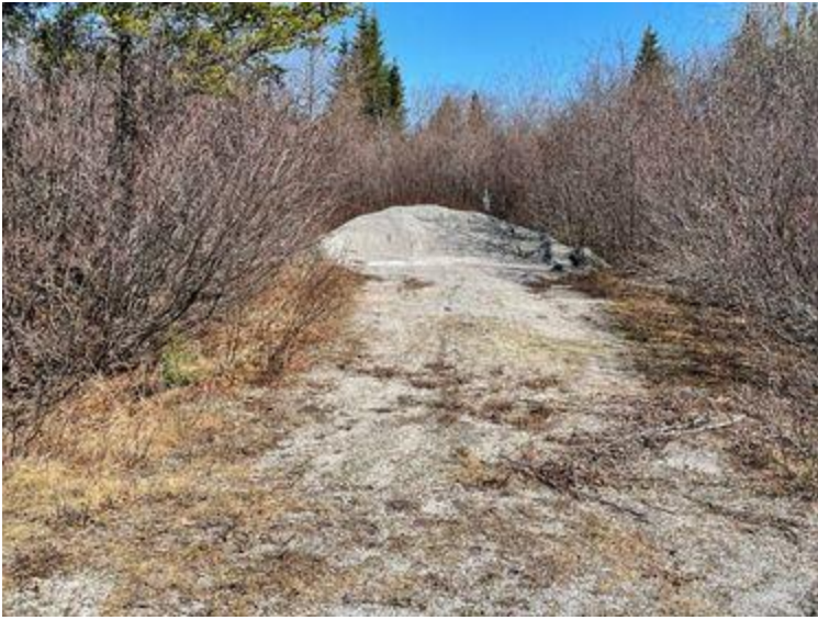
19 (en cours de travaux)
